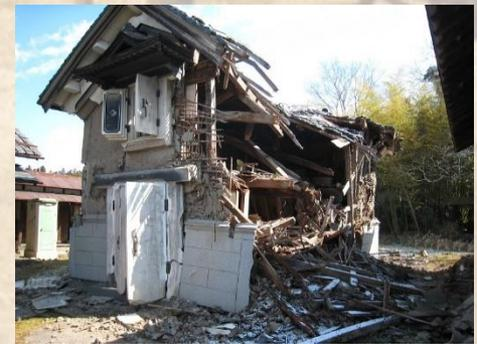
地震被害による土壁崩落
