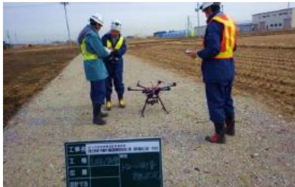
UAV（無人航空機）を用いた起工測量
