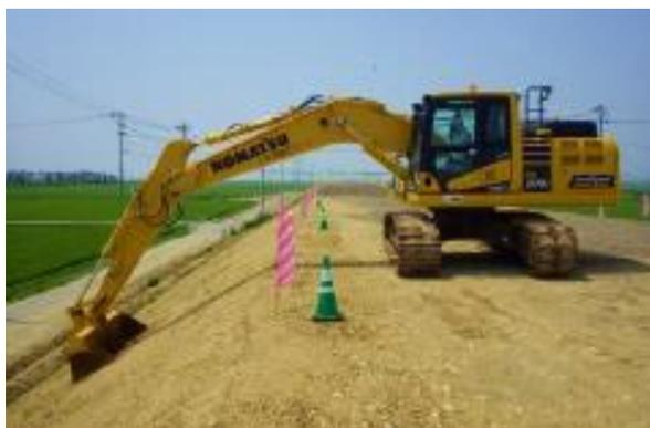
3DMC(※)バックホウによる法面整形
