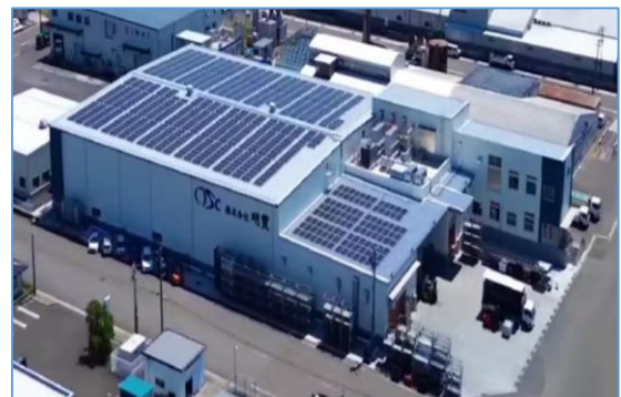
<当社工場屋根上太陽光設備の写真>
