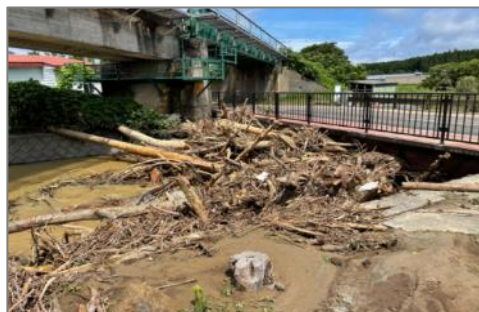
<災害復旧に関連した土木工事>
