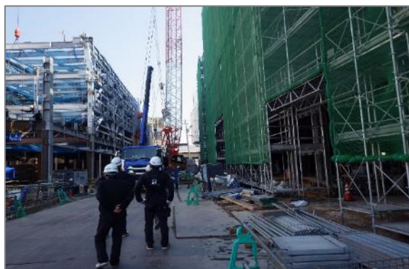
<現場パトロールの様子>
