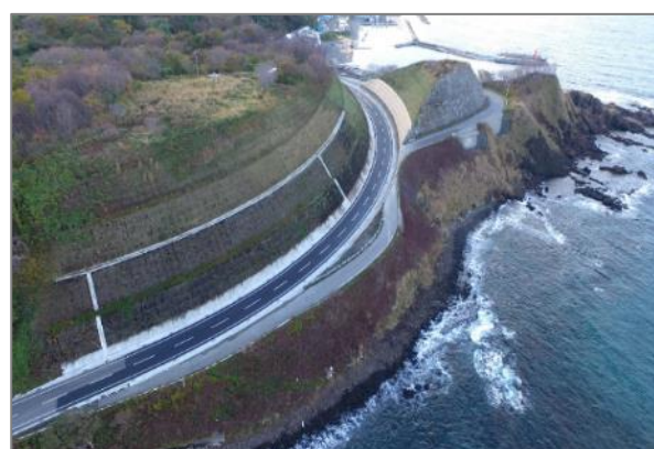
<国道 280 号「道路改築工事」（東津軽郡）>
