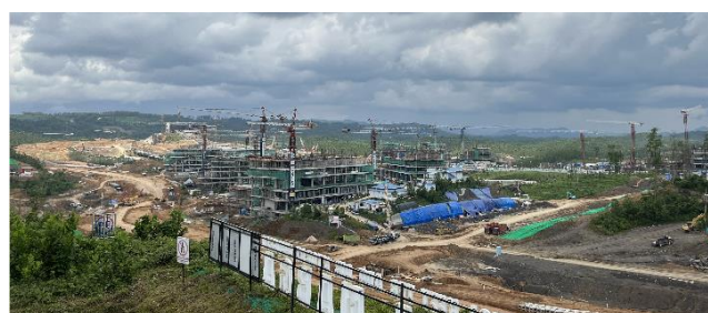
工事中の新首都ヌサンタラ (2024年2月撮影、JBICジャカルタ事務所提供)
