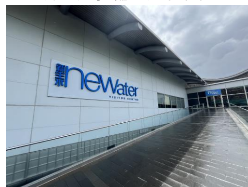
NEWaterの施設外観
