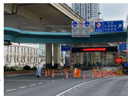
浦西から浦東へ向かうトンネルの封鎖状況
