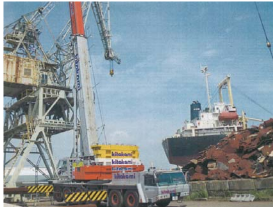
ABL実行例（大型クレーン）
