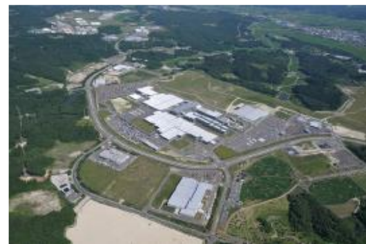
第二仙台北部中核工業団地
