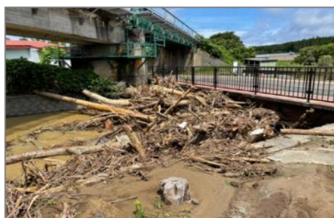
<災害復旧に関連した土木工事>
