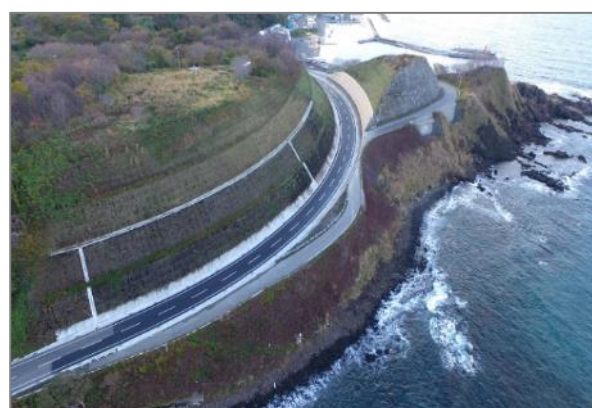
<国道280号「道路改築工事」(東津軽郡)>
