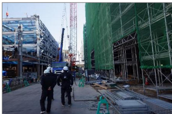
<現場パトロールの様子>
