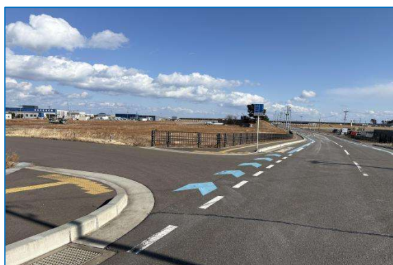
<名取市関上地区 震災復興工事>
