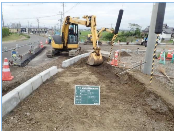
図表3：土木工事現場の様子（重機）
