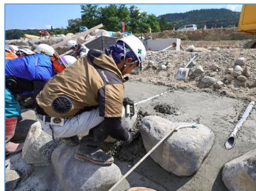
<図表 4:土木工事現場の様子(作業員)>
