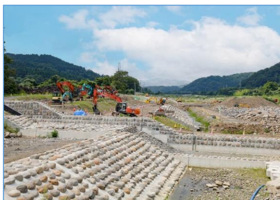
<図表 3:土木工事現場の様子(重機)>
