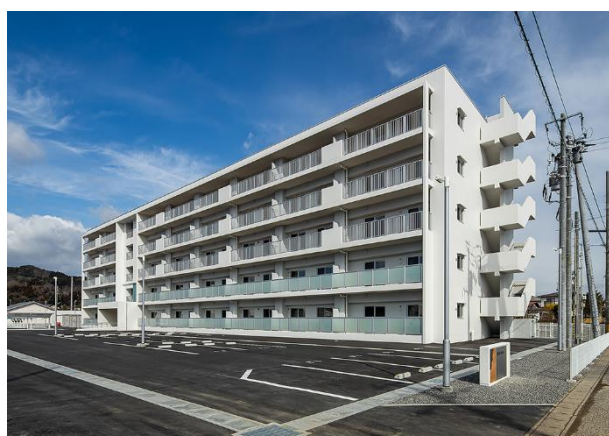
<図表5：丸森町営住宅神明4工区集合住宅>
