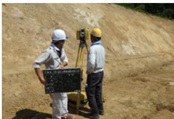
レーザースキャナーによる計測①
