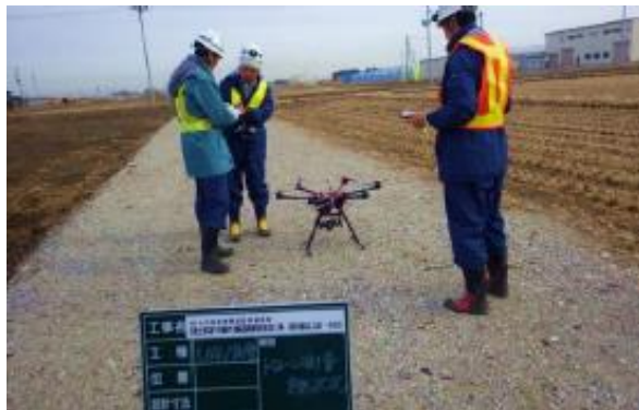
UAV（無人航空機）を用いた起工測量
