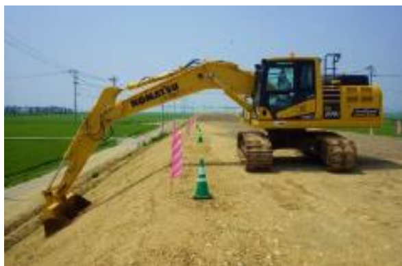
3DMC(※)バックホウによる法面整形 ※3次元設計データを搭載した ICT 建機を 半自動制御するシステム
