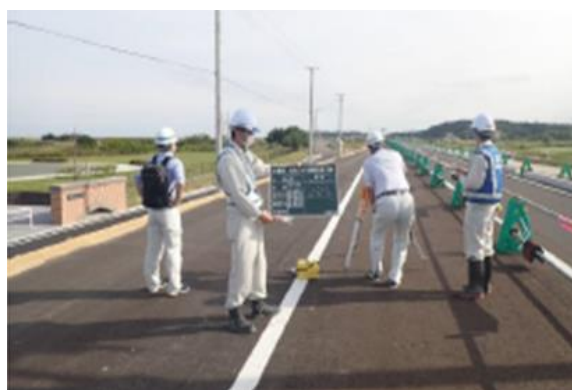
レーザースキャナーによる計測②
