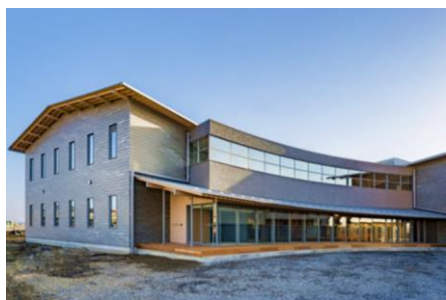
みやぎ登米農業協同組合本店・ なかだ支店 (サステナブル建築物等先導事業)
