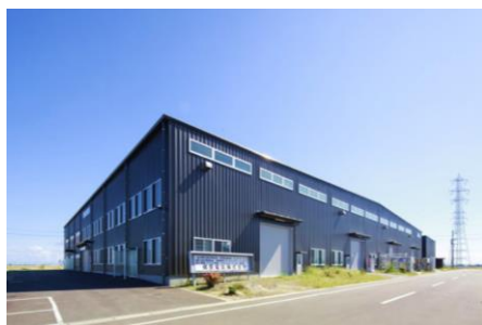
梶原電気(株)工場棟・塗装工場
